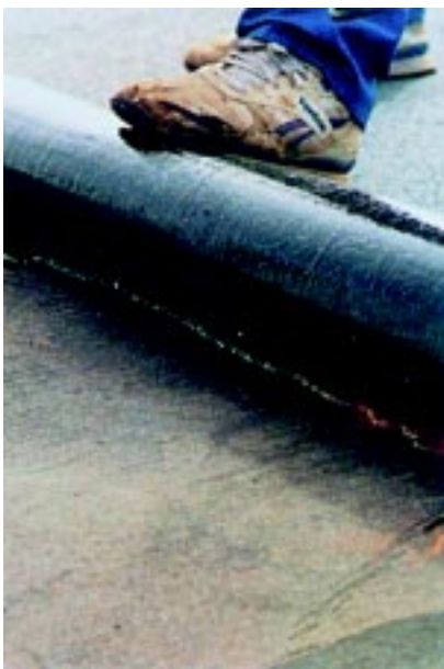
rys. 11 Montaż systemu wentylowanego na podłożu z żelbetu
