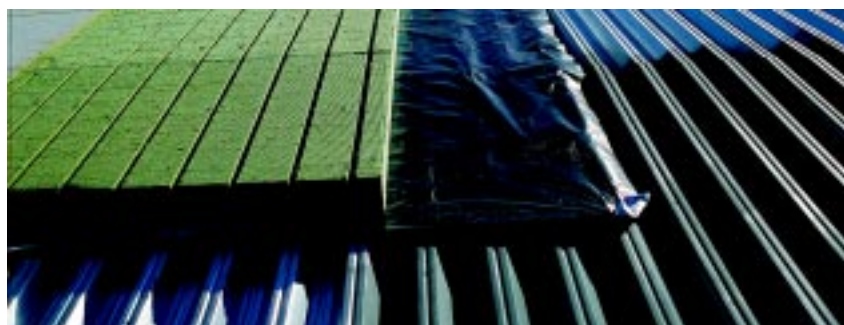
rys. 20 Mocowanie izolacji do podłoża z blachy trapezowej
