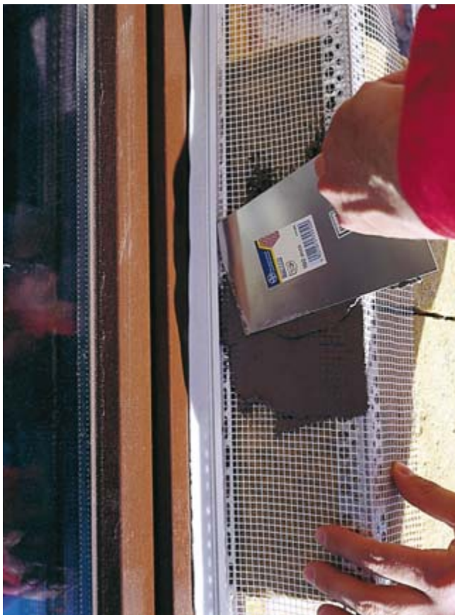
Ocieplenie ościeża okiennego z zastosowaniem listwy przyokiennej LP-ECOROCK.
